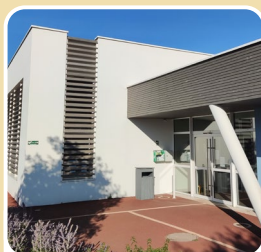
Salle des Pinsonnières : rue de Pinsonnières
