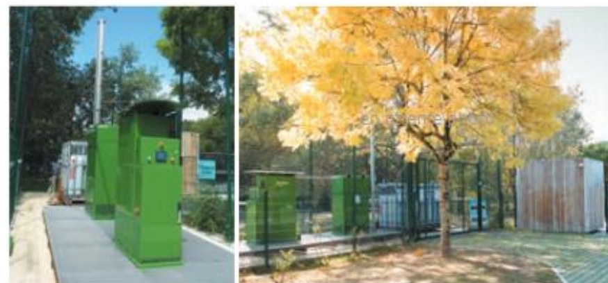
La station de compression, située à Port Boyer, est alimentée par des racks d'hydrogène sous pression 200 bar.
