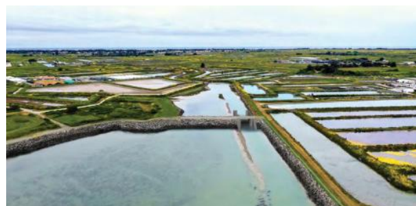
Figure 6 - Illustration de l'ouvrage de raccordement aux berges de l'étier des Coëfs, vue vers les terres
